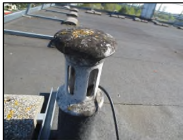
Photo N° 666 AMIANTE CIMENT -- Toiture terrasse Toiture Chapeau (Fibres-ciment)
